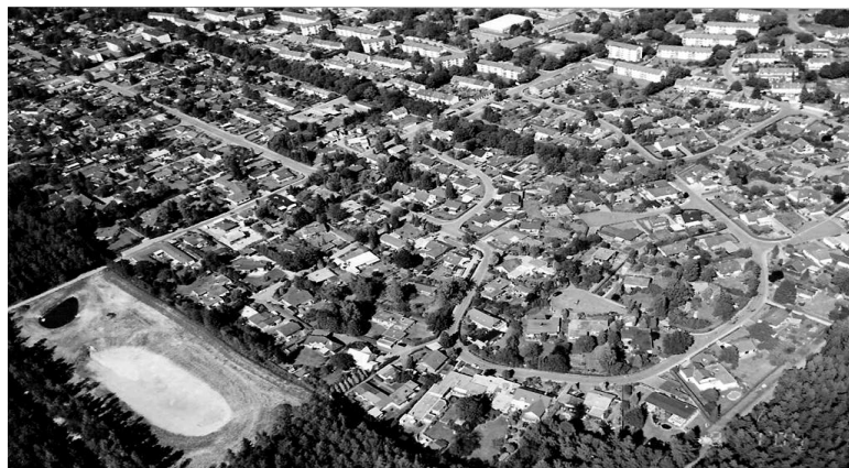
Regenklärbecken an der Kurlandstr.
